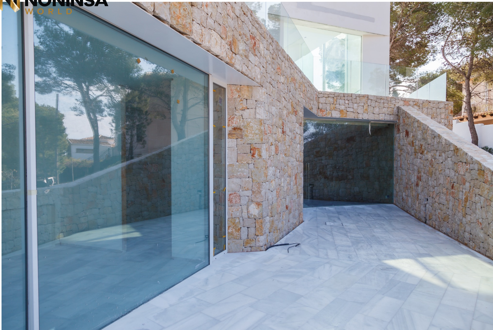
Pavimento exterior - Blanco Macael arenado
