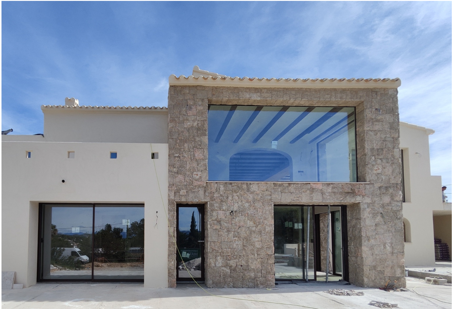
Revestimiento exterior en Cubic Emperador Castril.
