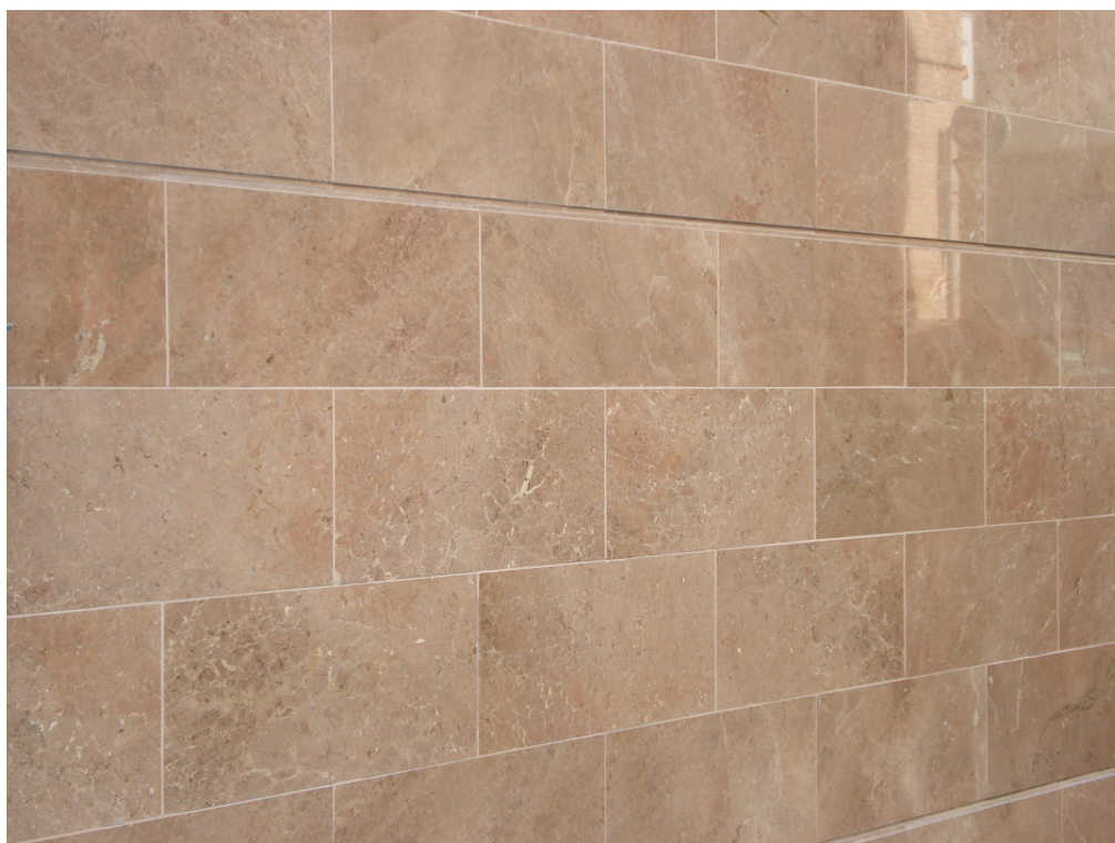
Revestimiento realizado con piezas de Rosa Zarci, mostrando la variación natural entre placas.
