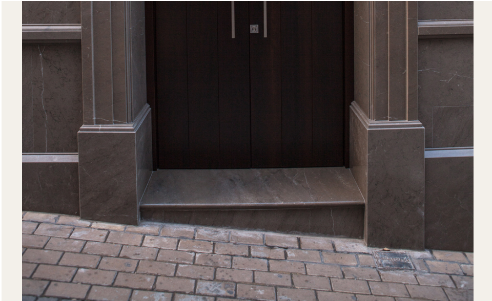
Escalera · continuidad cromática y veteado fino
