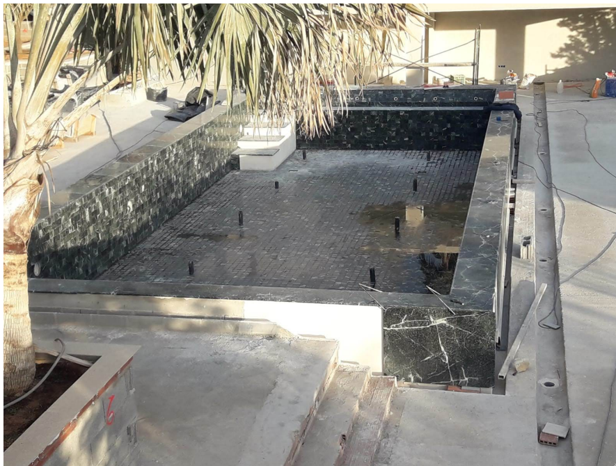
Aplicación exterior: combinación de mosaico y piezas especiales.
