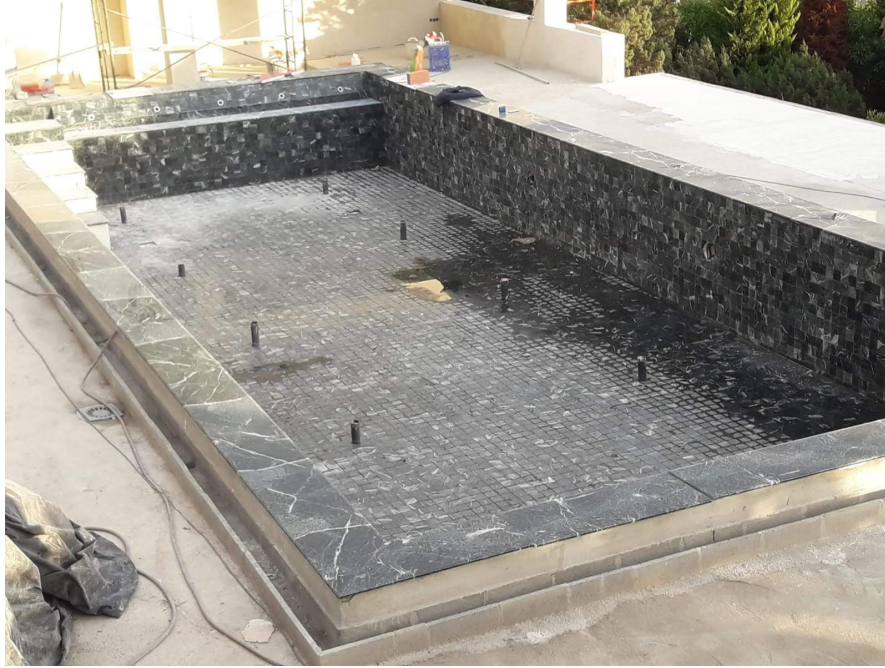
Revestimiento de vaso, pavimento en mosaico y coronación.
