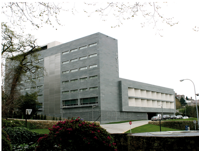
Aplicación en fachada
